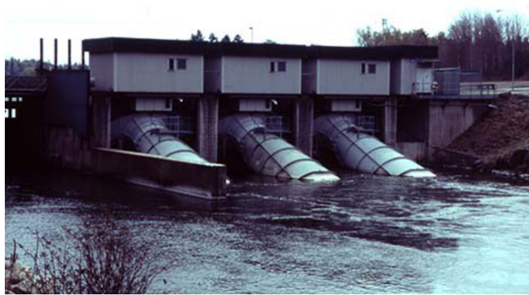
Älvås kraftverk i Motala Ström använder Rörkaplanturbiner.
